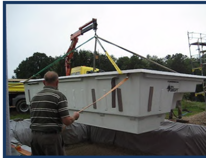
Setzen des Beckens:
